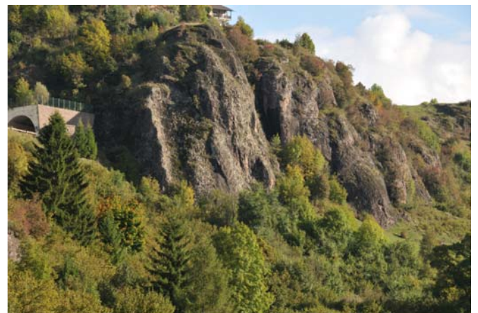
Il sito è attraversato da viabilità primaria (con tre gallerie)
