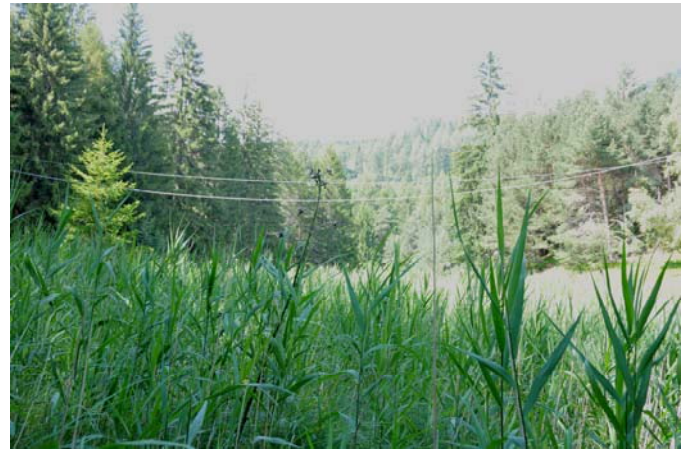
Particolare: l'attraversamento della linea elettrica
