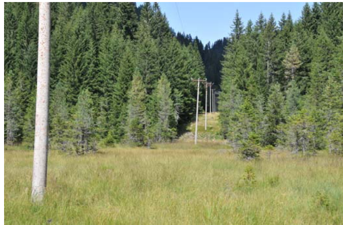
Una linea elettrica attraversa in sito da nord a sud
