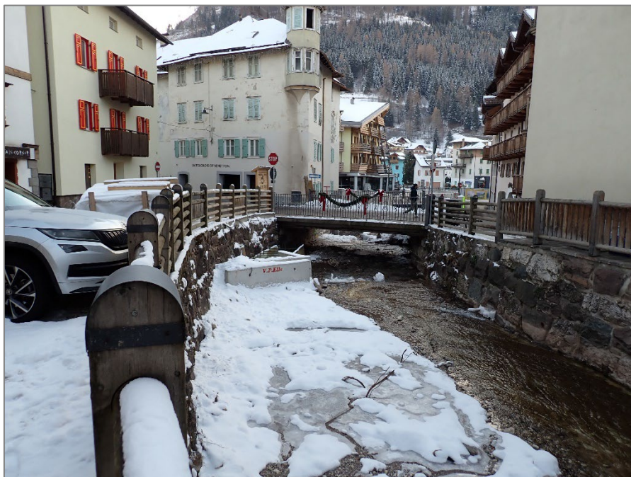
Sopralluogo dicembre 2024 - Rio Costalunga vista da monte verso valle da Strada del Marchiò. A valle del ponte, in sinistra orografica, si vede l'ex Hotel Corona.
