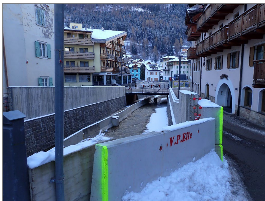
Sopralluogo dicembre 2024 - Rio Costalunga vista da monte verso valle da via Lowy. In sinistra orografica, tra il ponte che collega le strade comunali Strada Cirillo Dellantonio e Corso D Bora e il ponte sulla strada Riccardo Lowy, si vede l'ex Hotel Corona.
