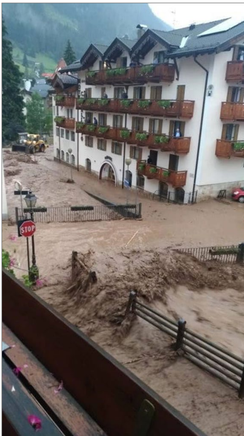
Ponte della strada comunale (vista da monte verso valle).
