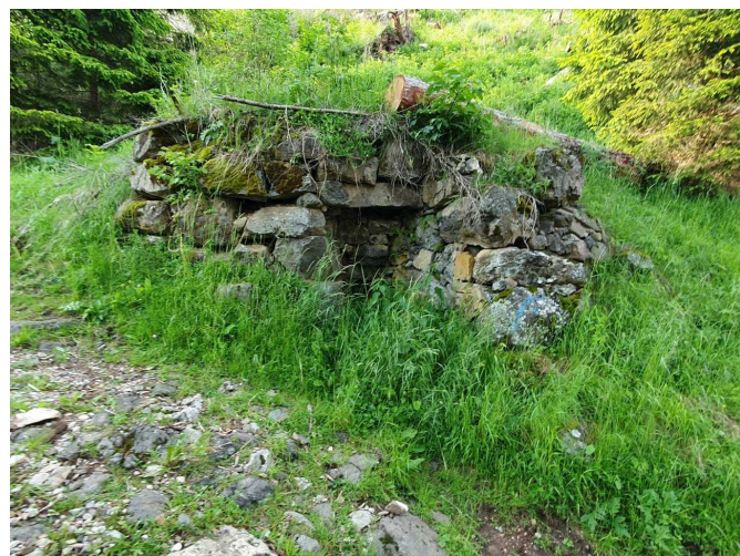
Foto 3. Manufatto nei pressi da tutelare
