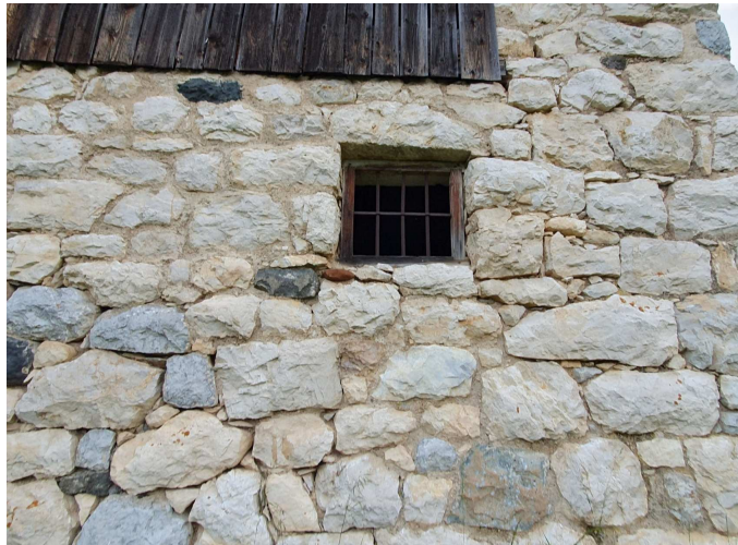
Foto 4. Particolare tecnica muro in "raso sasso"
